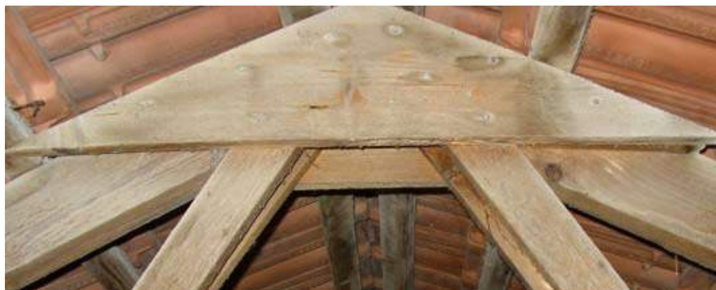
חיבור אופייני בגג אגדים מעץ - האלכסונים עשויים משני לוחות חובקים.
