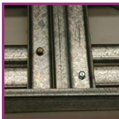
חיבור אופייני בגג מפרופילי פלדה "אולטראספן" של מייטק.
