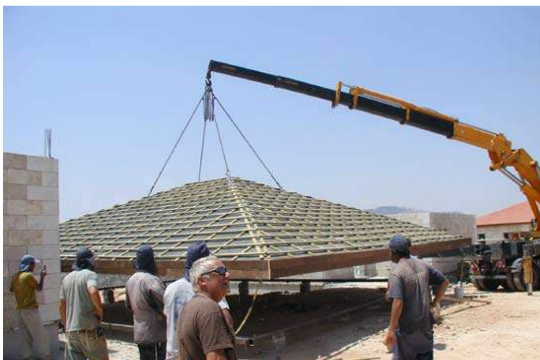
הרכבת גג על גבי הקרקע והנפתו כיחידה אחת
