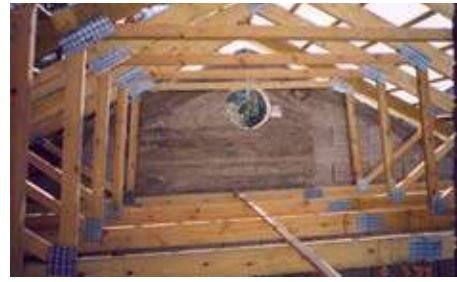
ייצור אגדים מתועשים תוך שימוש במחבר הממוסמר
