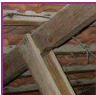
חיבור אופייני באגד מעץ. האלקסונים עשויים מלוחות
