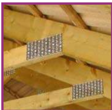
חיבור באגד עץ עם מחבר מדגם " CAM " של מייטק
